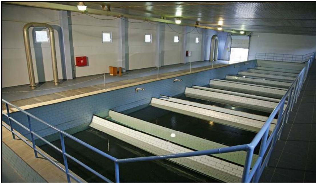
Obr. č. 2 Úpravna vody a jímací objekty podzemní vody
